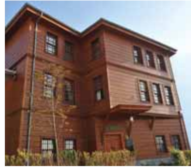
Üsküdar Balaban Tekkesi Restorasyon
