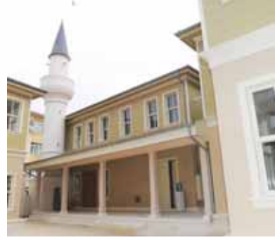
Üsküdar - Nalçacı Dergahı Restorasyon
